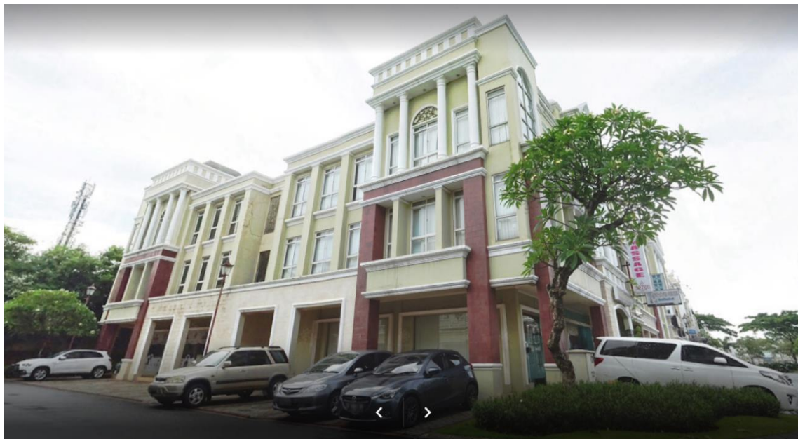
Gambar 1. Gedung Kantor Loka POM di Kabupaten Tangerang
